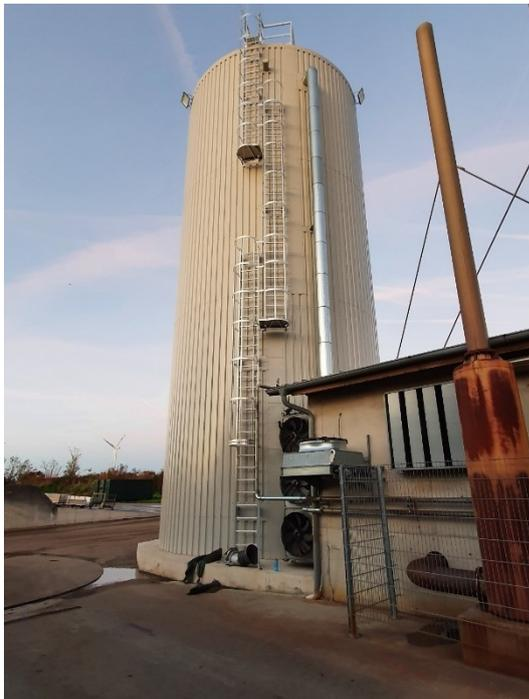
Abbildung 5: Ein großer Wärmepuffer zum Speichern von Wärme für eine Fernwärmeleitung
